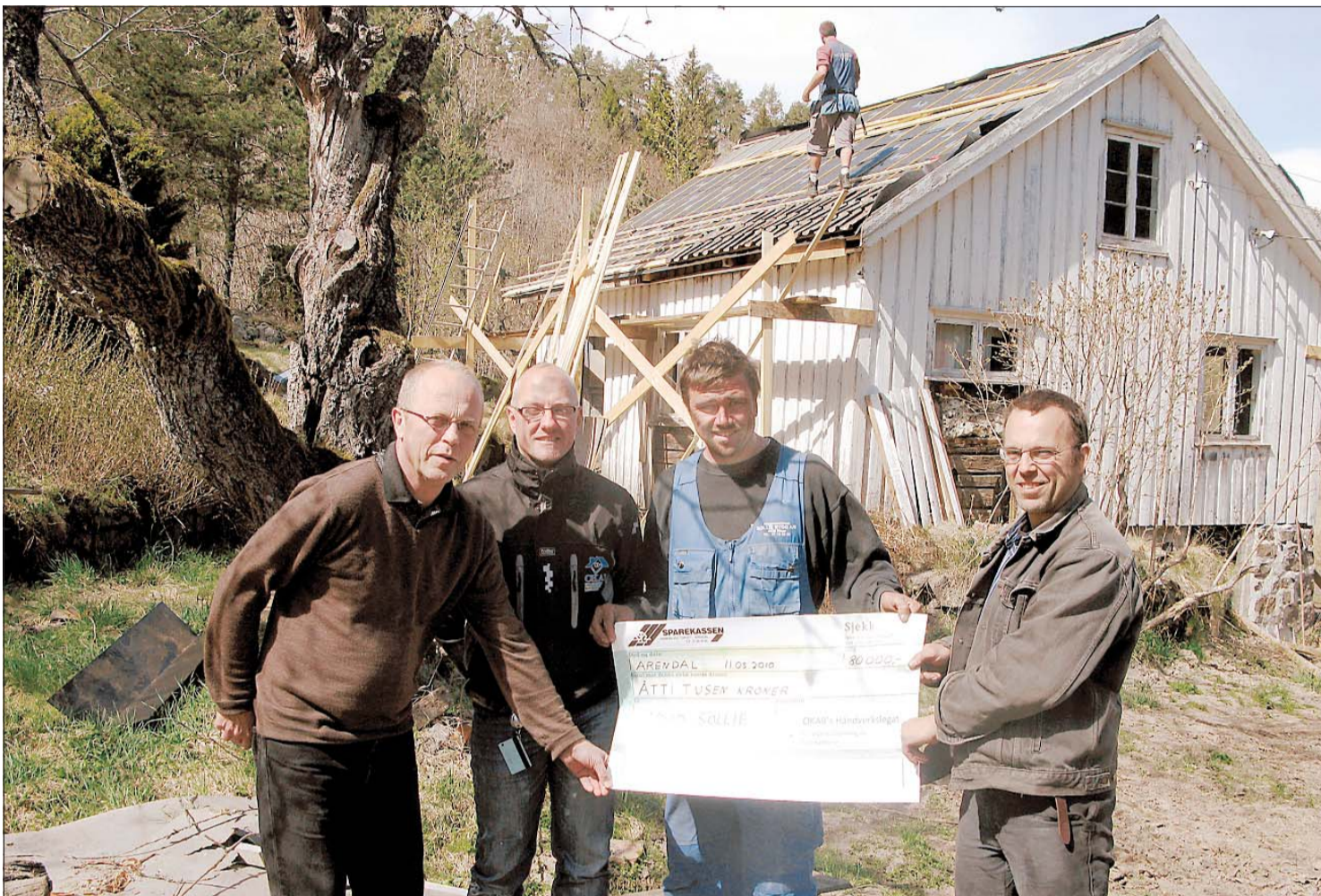
ROS OG RIS: Arvid Sollie fikk legatpenger og heder fra Knut Guttomsgaard, Glenn Kruse og Erik Gjendem på Opplæringskontoret. Men Fellesforbundet lar seg ikke blende av sjekken og rystes av stillaset i bakgrunnen. Sollie sier han jobber på huset i fritiden og ikke gjennom firmaet.
