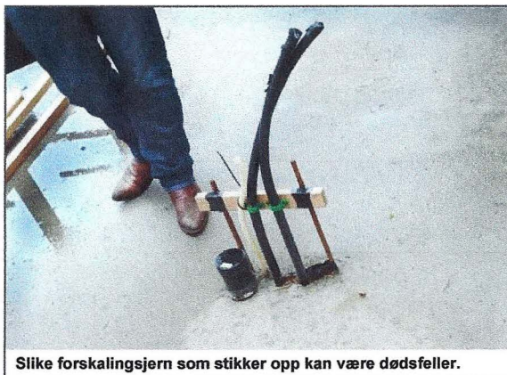
Slike forskalingsjern som stikker opp kan være dødsfeller.
