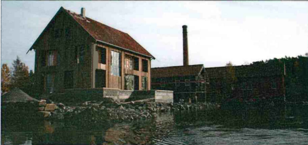
RESTAURERER BÅBYGGERI: Eigil Stray Spetalen bruker store summer på å restaurere og bygge på vakre Lekerøya utenfor Risør. Foto: Arbeidstilsynet
